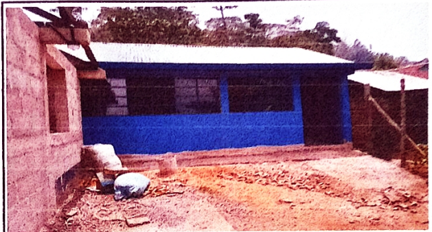
Foto 8: Susustritucion de canales pluviales
