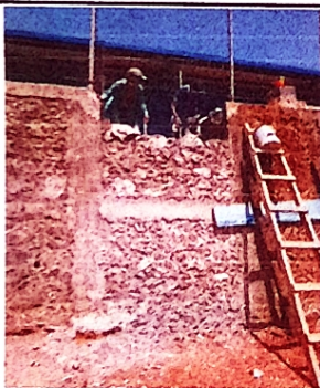
Foto 15 reparacion de muro de contencion
