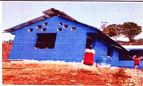
Foto 16: Reparacion de pared de cocina.
