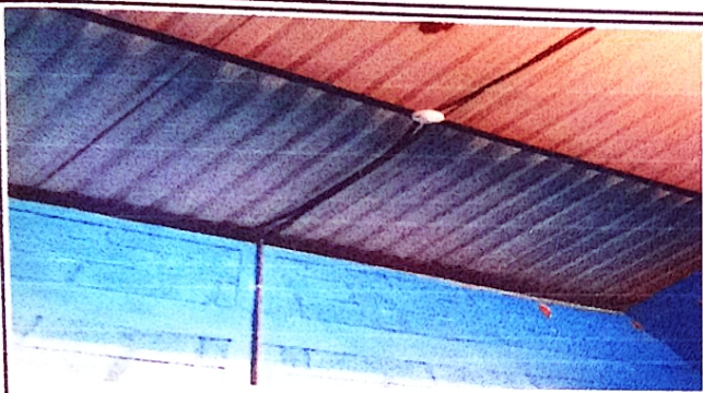
Foto 13: Reparacion de sistema electrico
