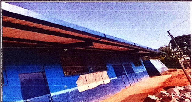
Foto 6 Sustitucion de canales pluviales
