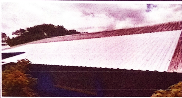
Foto 1: Reparación de cubierta de lamina a troqueladas
