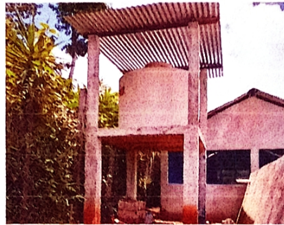
foto 4: construccion de base para tinaco
